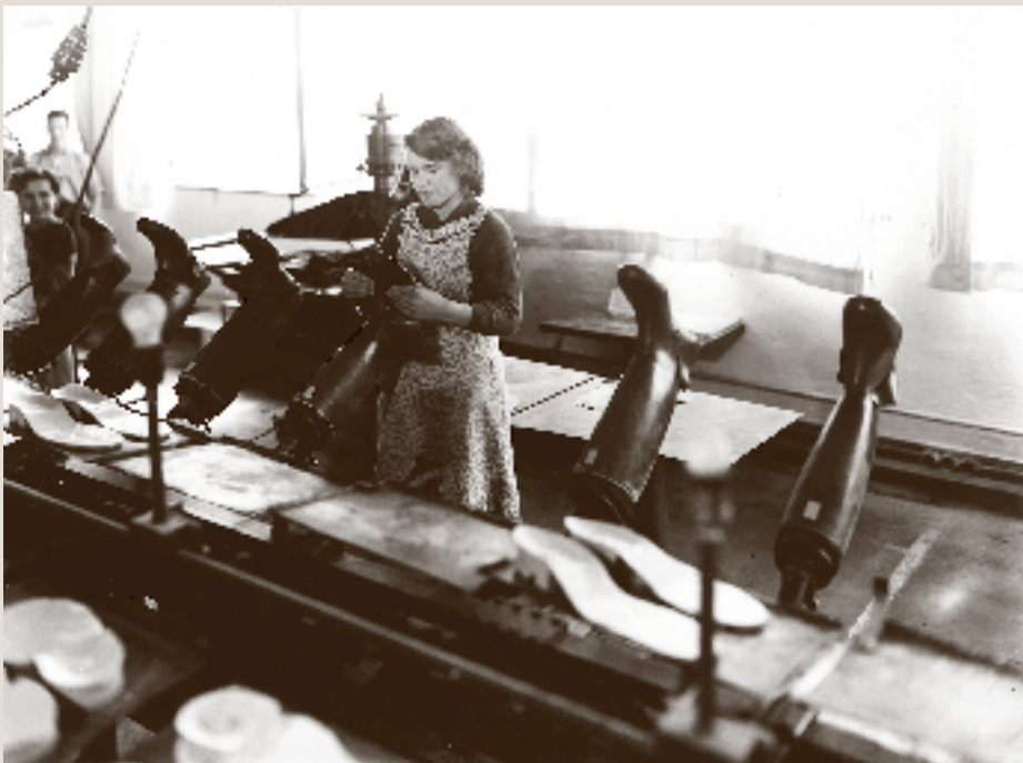
Abbildung 44 Für den innovativen Schuhkonzern Bata waren die Bewirtschaftung des Werkstoffs Gummi und der Einsatz des Fließbands charakteristisch. Auf dieser Werkfotografie aus Möhlin im Jahr 1954 wird das laufende Gummistiefel-Band in Szene gesetzt.
