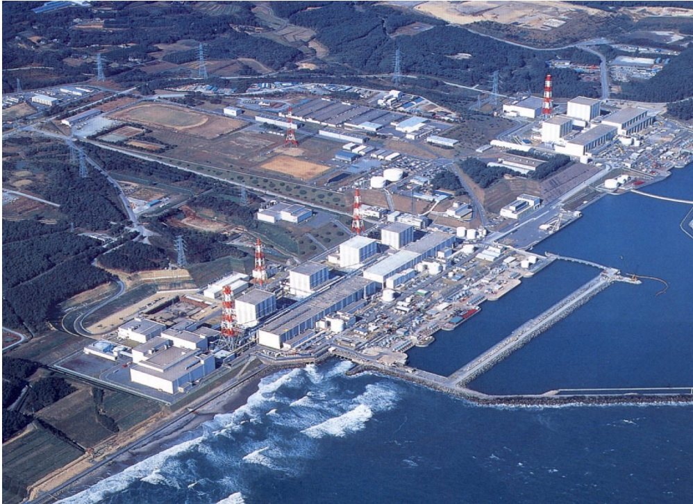
Figure 2 : La centrale nucléaire de Fukushima Daiichi avant l'accident. De gauche à droite les réacteurs 4, 3, 2, 1, 5 et 6
