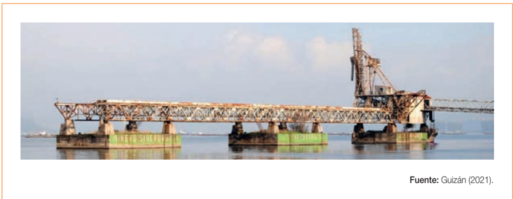
Figura 5. Cargadero de Coto Wagner (Redondela)
