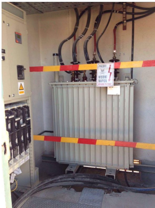
Slika 4 Transformator s jezgrom od amorfnog materijala u TS Dugopolje-4
