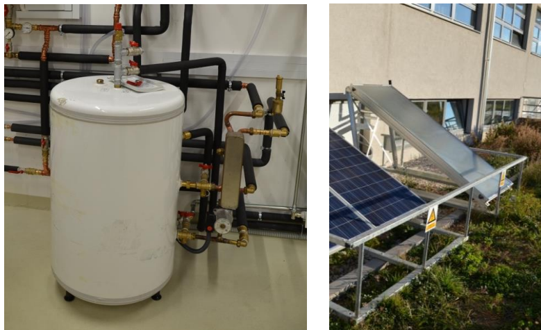
Slika 2 Solarni toplinski spremnik s pločastim izmjenjivačem topline; solarni toplinski pretvornik
