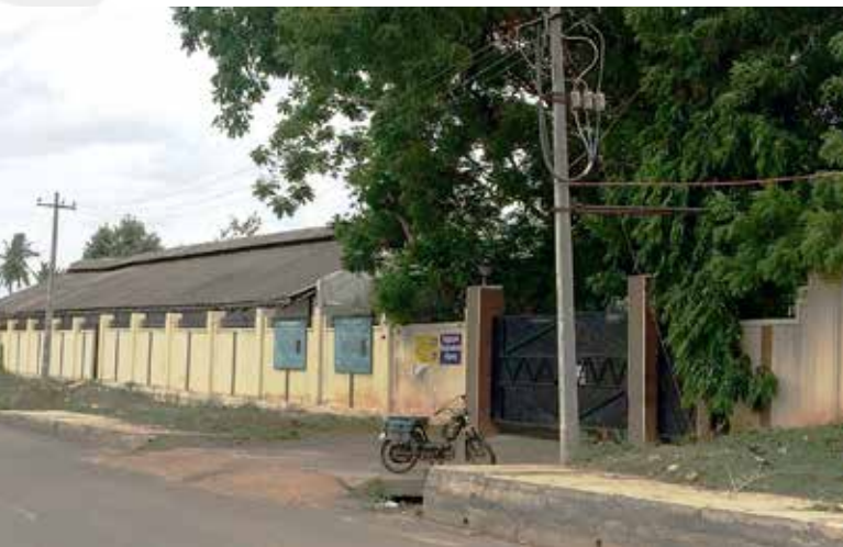
Außenansicht von Gerberei 3 in der Nähe Amburs
